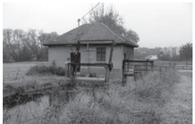
Turbinenhaus der Pflugbrauerei Rottweil 2005
